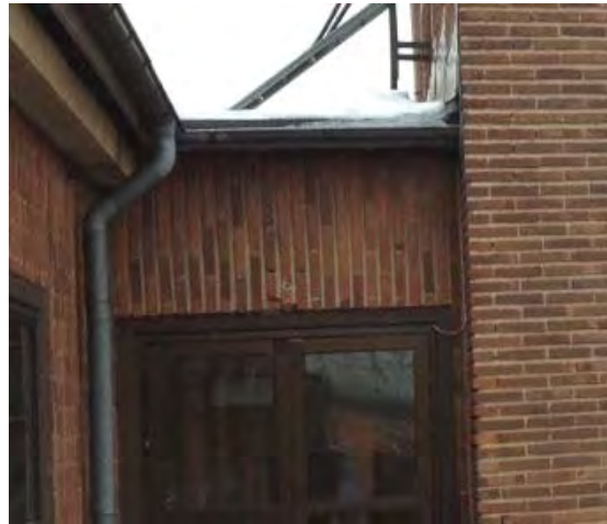
Det smala teglet och stående förband är karaktärsavgörande för fabriksbyggnaden.
